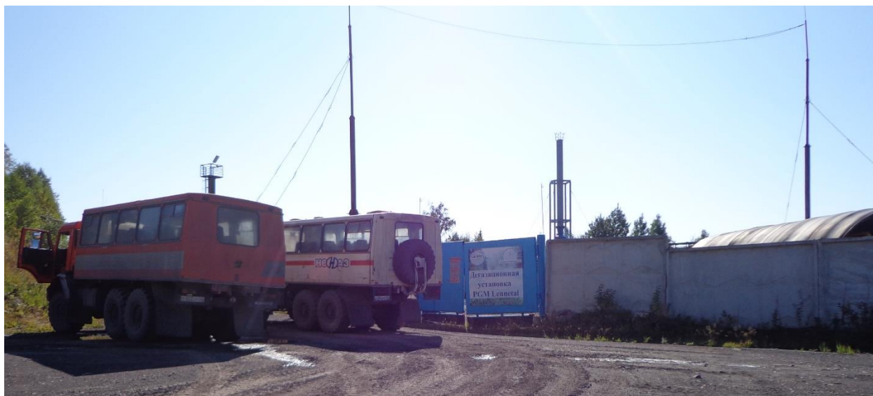
Рисунок 2.2.5 – Площадка дегазационной установки №1 шахты «Сибиргинская»
