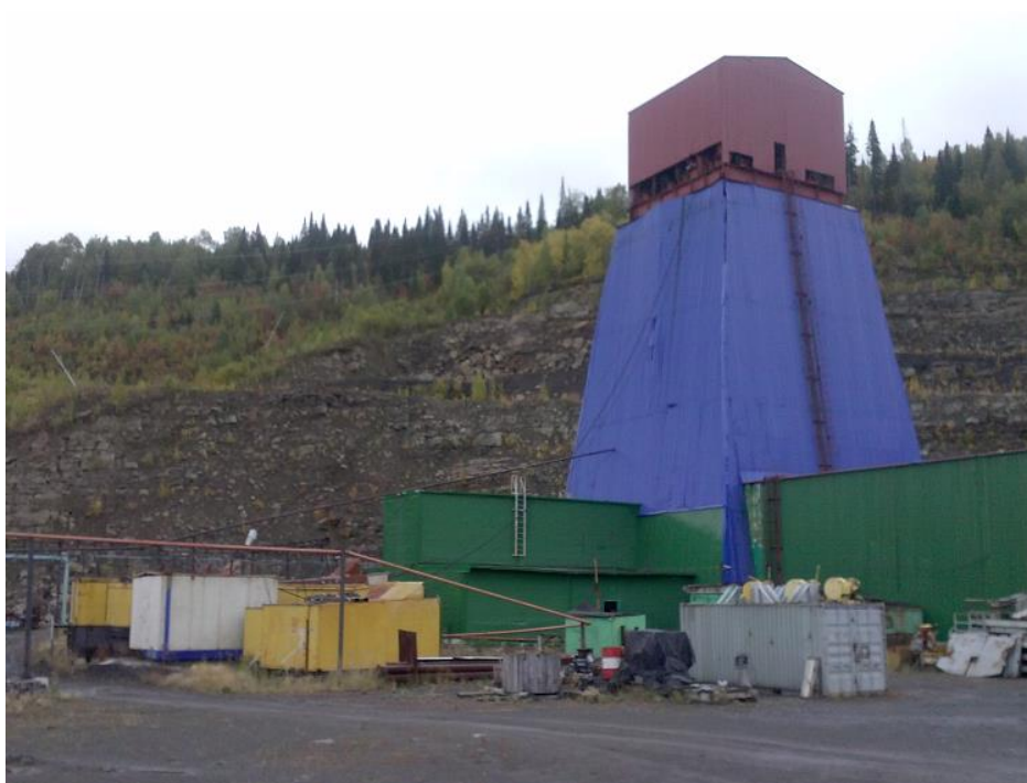
Рисунок 3.3.5 – Площадка вертикального вспомогательного ствола
