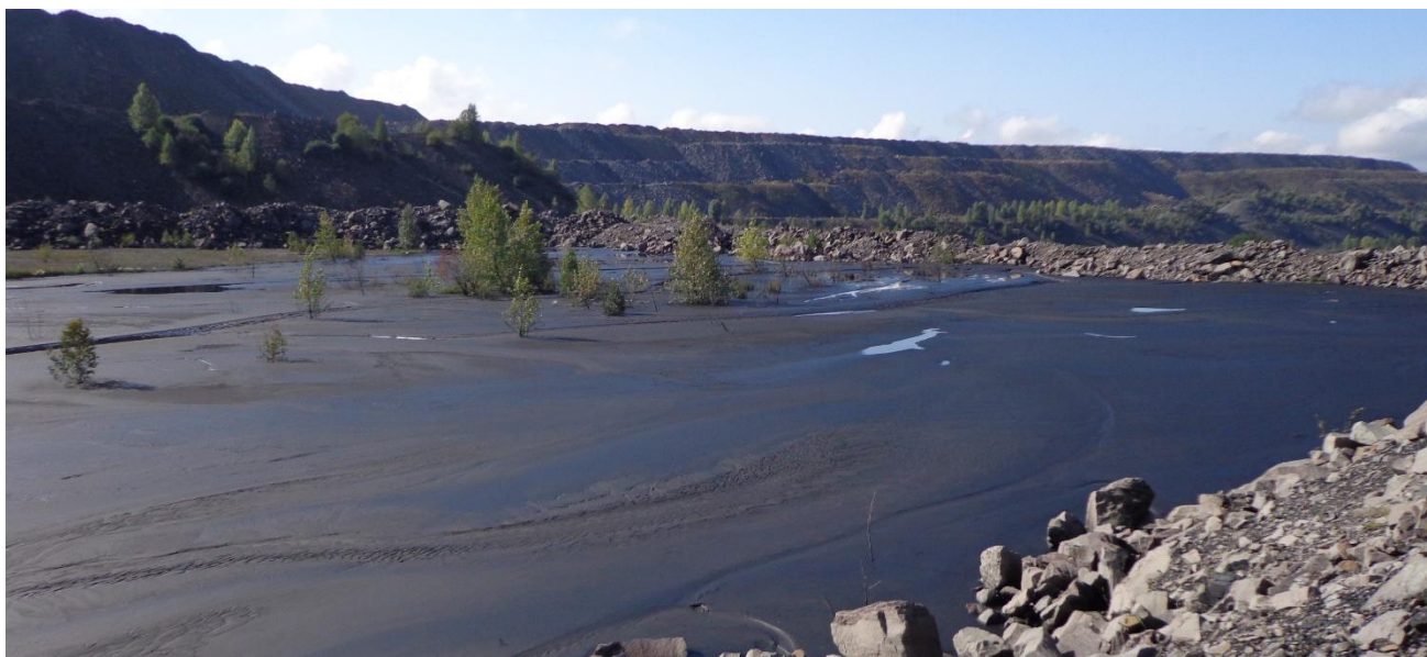
Рисунок 2.2.2 – Площадка отстойника шахтных вод шахты «Сибиргинская»
