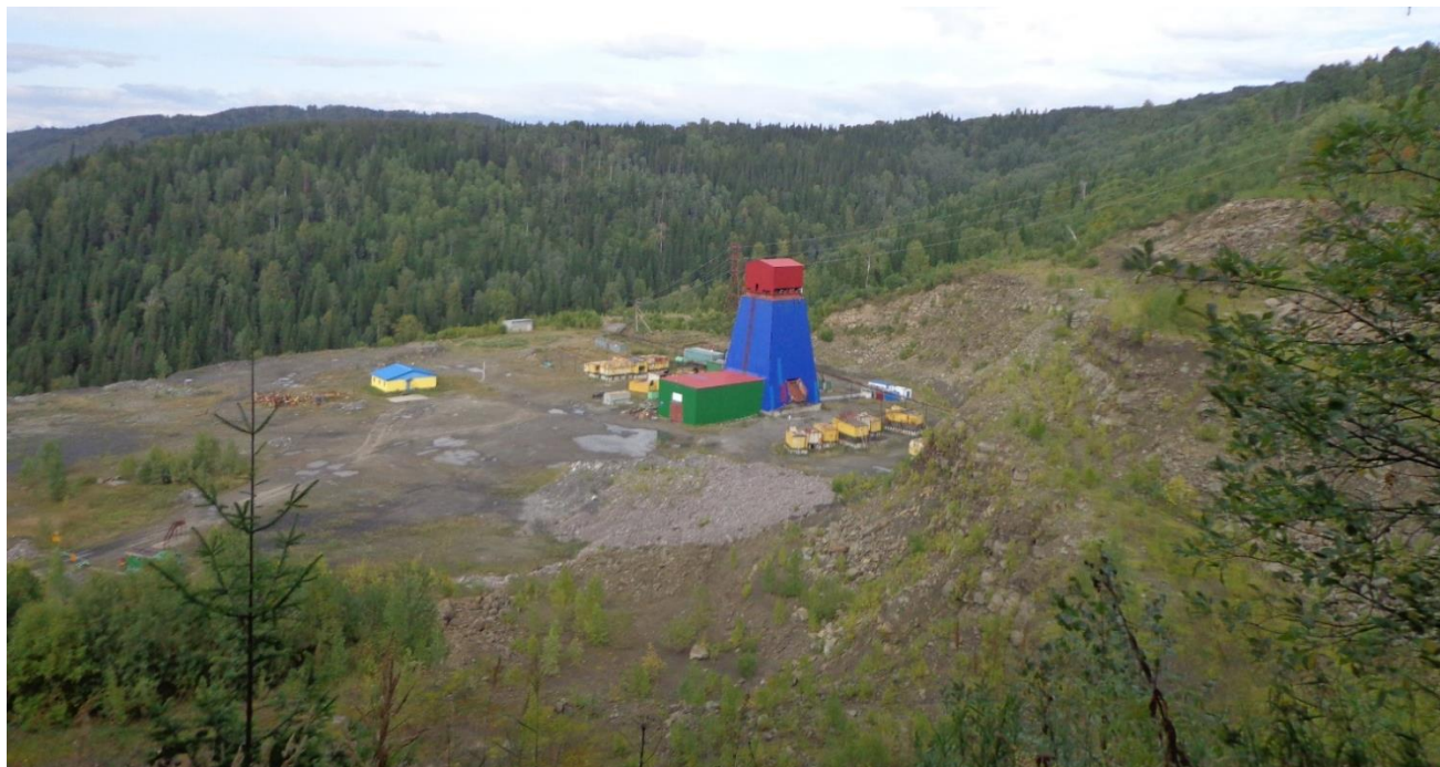
Рисунок 2.2.3 – Площадка вертикального вспомогательного ствола шахты «Сибиргинская»
